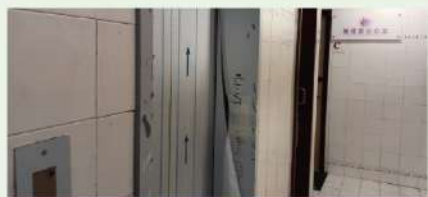
大廈更換電梯完工
